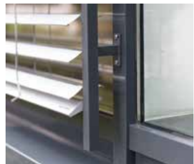
Führungsschiene mit Abstandhalter
